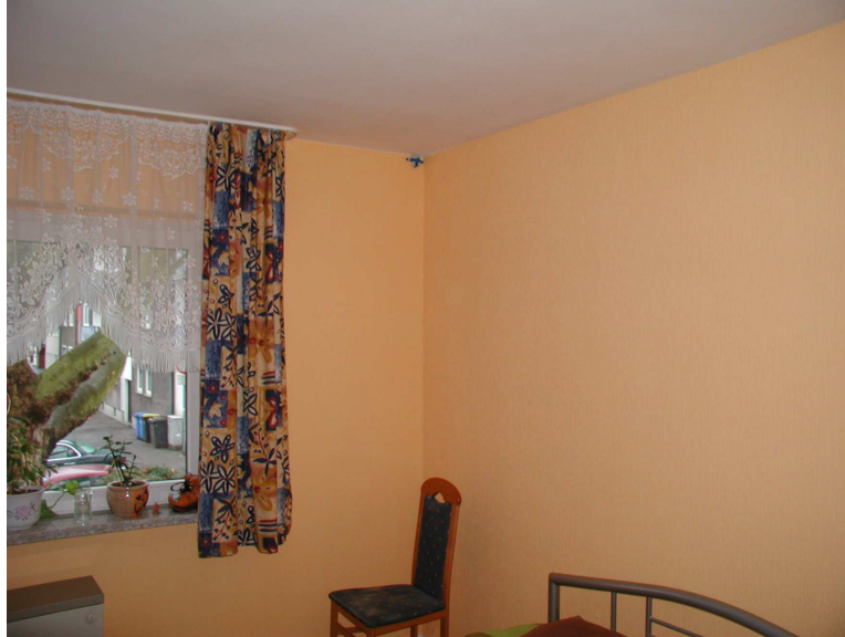
Bild 1: Schlafzimmer, Übersicht Außenwand
